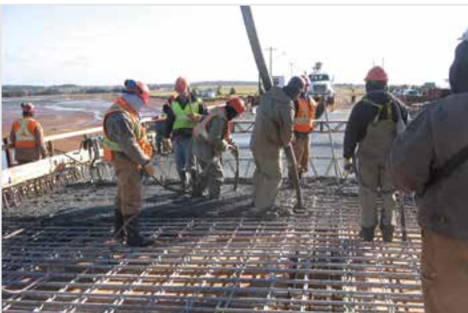
Victoria Brücke, Kanada
