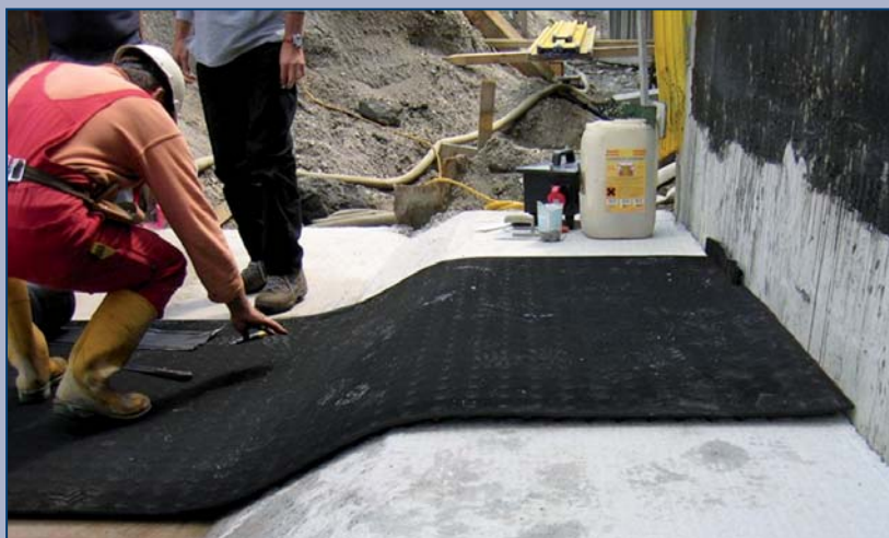
Rysunek 1: Układanie mat
